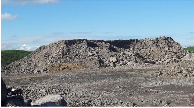
Uppfyllingarefni á framkvæmdarsvæði Urriðaholts ehf. sem notað var til að hækka botnsstöðu Oddsmýrarlækjar.
