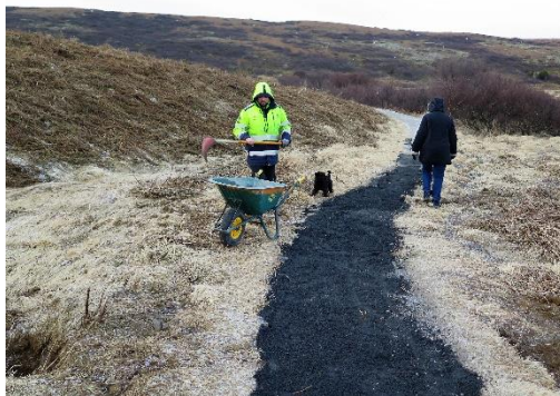
Unnið að lagfæringu stígs.
