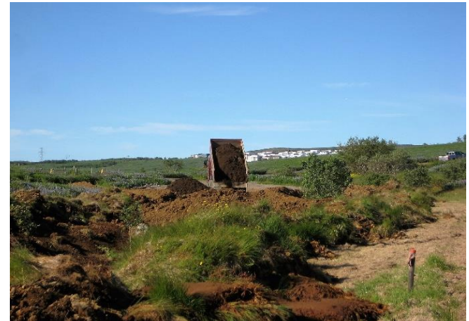
Uppfyllingarefni keyrt á verkstað frá Urriðaholti ehf.
