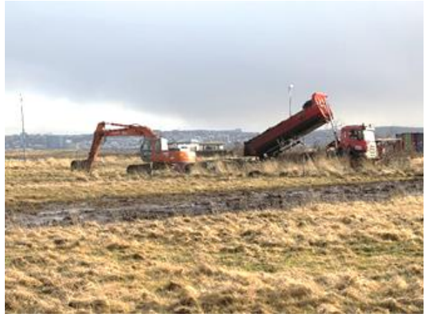
Móttaka efnis. Vörubíll flutti efnið frá efnislager þar sem beltagrafa tók á móti því og keyrði í skurðina.
