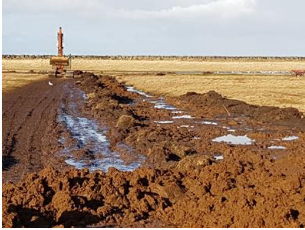
Beltavél keyrir meðfram skurði og fyllir upp í hann. Þennan dag sem myndin var tekin bar á komu farfugla sem fylgdu vélinni í leit að æti.
