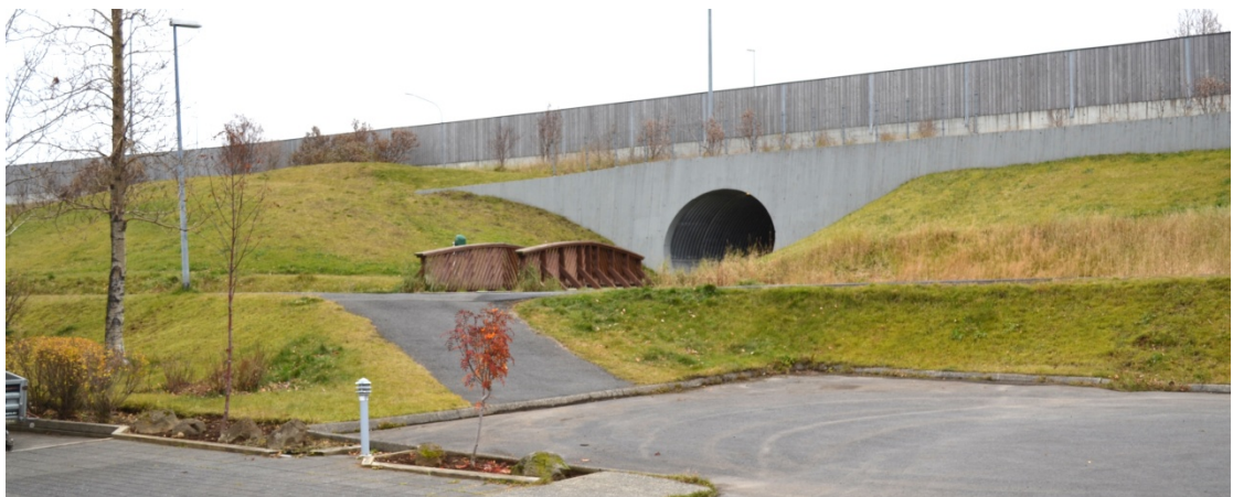
Hljóðvarnaveggur meðfram Reykjanesbraut, brú yfir Arnarneslæk, undirgöng að Hnoðraholti
