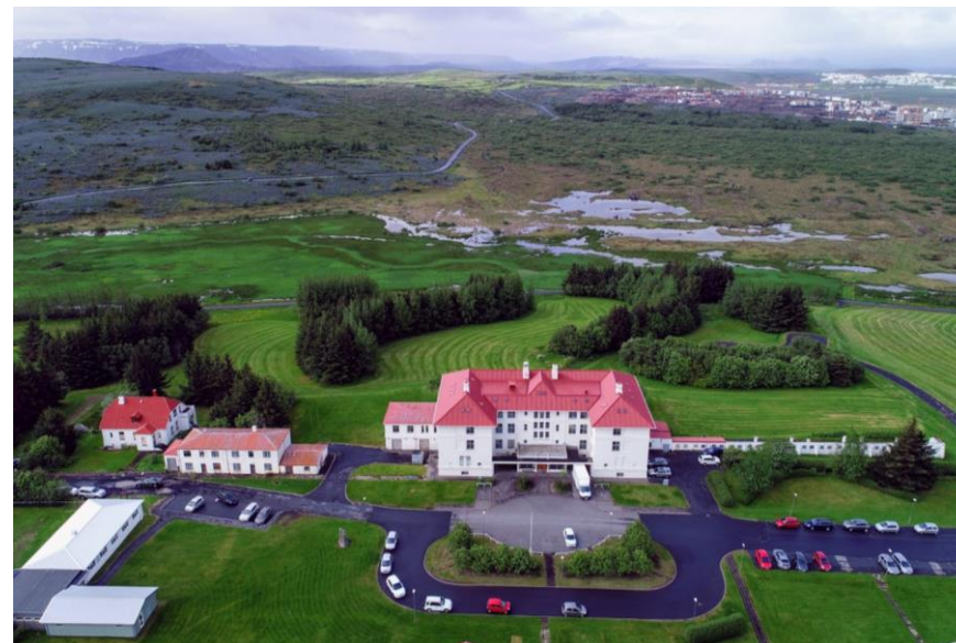
MYND 46 Flugmynd, horft til suðurs yfir Vífilsstaði, skrudgarð og Vatnsmýri.
