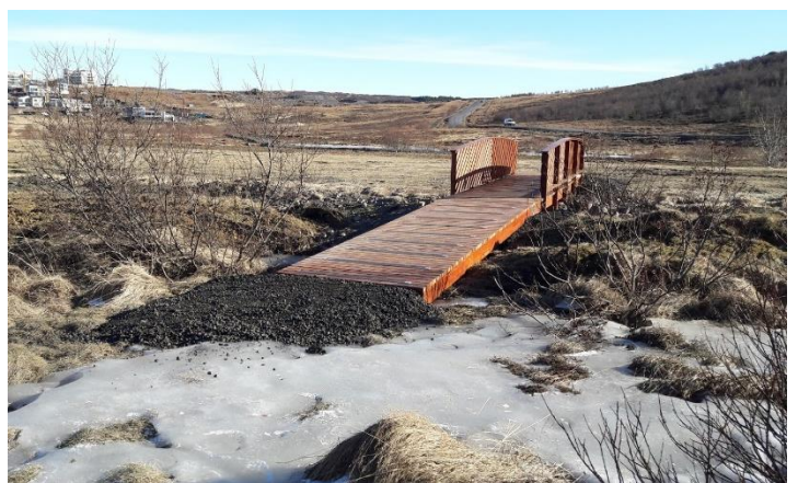
Göngubrú og rampur.
