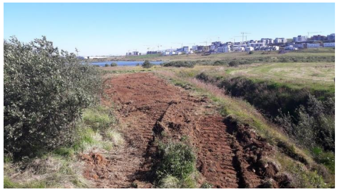
Jarðýta fór yfir svæðið án þess að skilja eftir djúpa skurði í gróðurverðinum.
