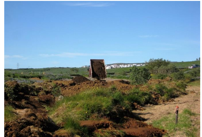
Uppfyllingarefni keyrt á verkstað frá Urriðaholti ehf.
