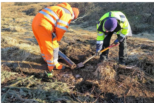
Starfsmenn garðyrkjudeildar hreinsa stífluð rör.
