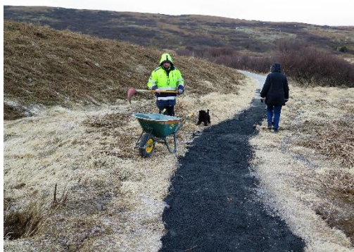
Unnið að lagfæringu stígs.
