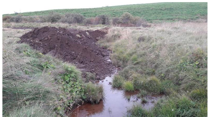
Botnsstaða lækjarfarvegs hækkuð með uppfyllingarefni.
